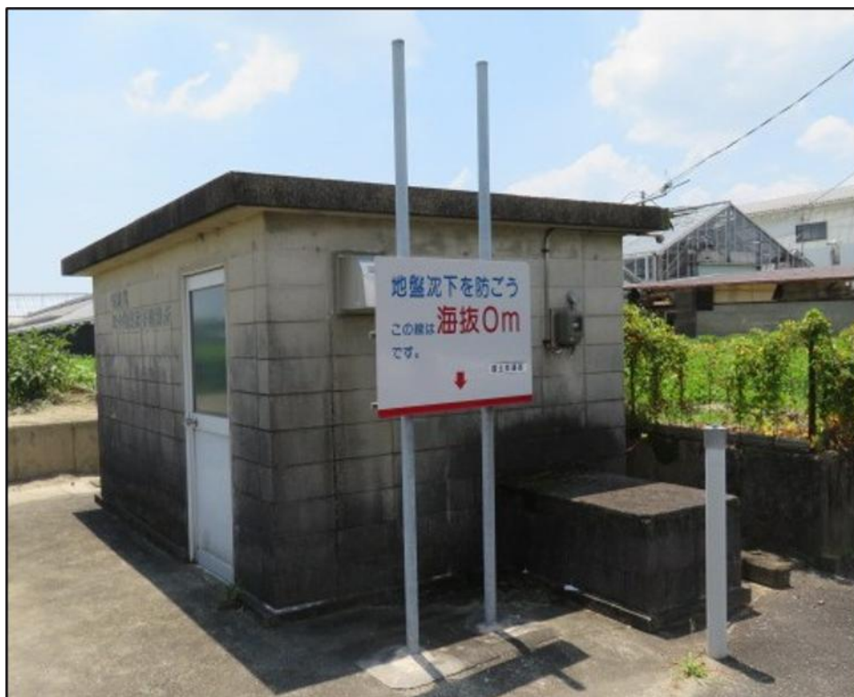
写真－7 三重県桑名市長島町松蔭 松中地盤沈下観測所の海水面レベルの表示（令和8年7月撮影）
