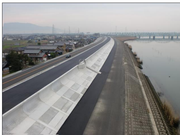
高潮堤防の遠景（平成22年3月撮影）
