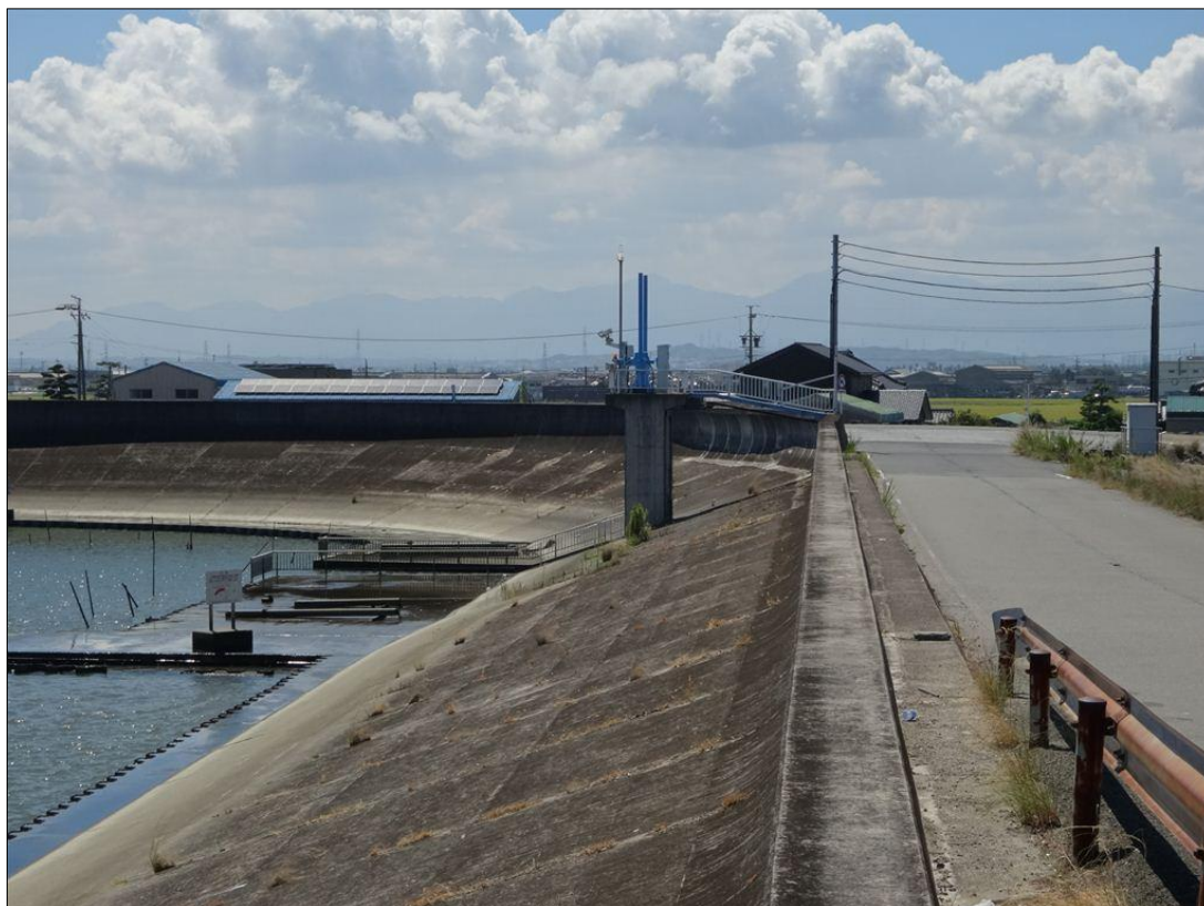
写真－10 地盤沈下対策河川事業（三重県桑名郡木曽岬町大字源緑輪中） （平成27年8月撮影）
