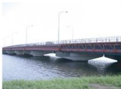
新篠川橋水管橋
