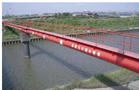
新善太川橋水管橋
