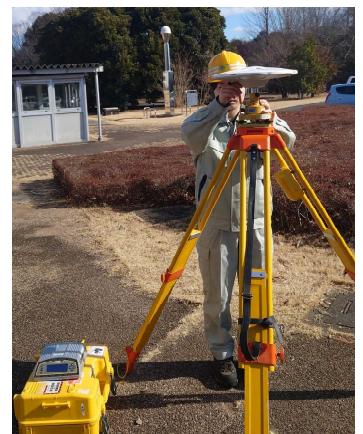
GNSS標高測量
