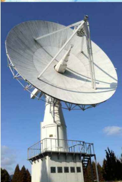
始良VLBI観測局 (鹿児島県) 完成: 1997年3月 アンテナ直径 10m 駆動速度 3°/秒 2015年3月運用終了
