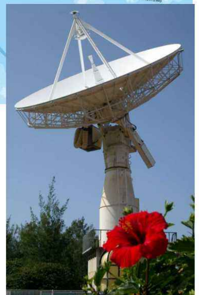
父島VLBI観測局 (東京都) 完成: 1997年3月 アンテナ直径 10m 駆動速度 3°/秒 2015年2月運用終了
