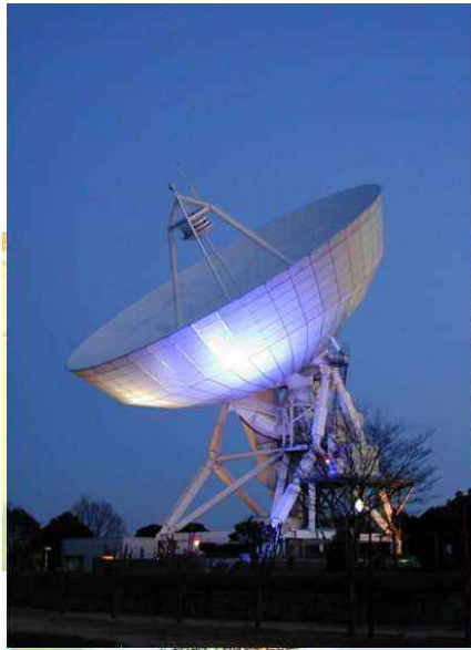
つくばVLBI観測局(茨城県) 完成: 1998年3月 アンテナ直径: 32m 駆動速度: 3°/秒 2016年12月運用終了
