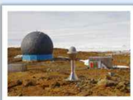
GNSS連続観測(写真中央)
