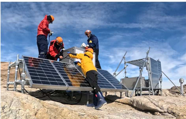
ラングホブデでの衛星通信装置の設置作業
