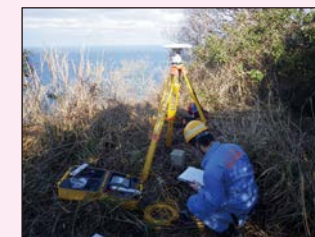
被災状況調査班による緊急測量
