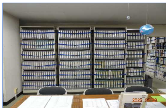
落下防止対策の本棚ベルト（中部地方測量部）
