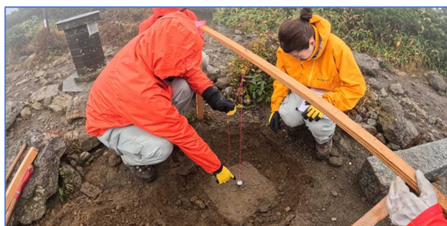
一等三角点「三倉山」保全作業（測地部）
