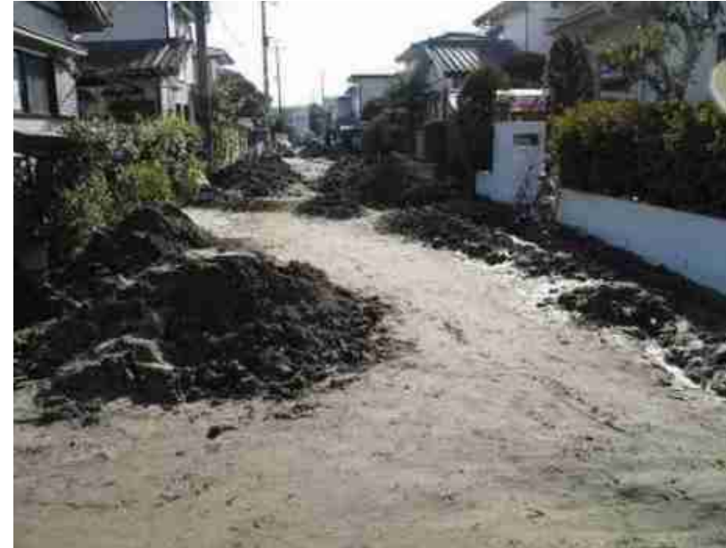
平成23年東北地方太平洋沖地震により発生した液状化 (国土交通省資料)
