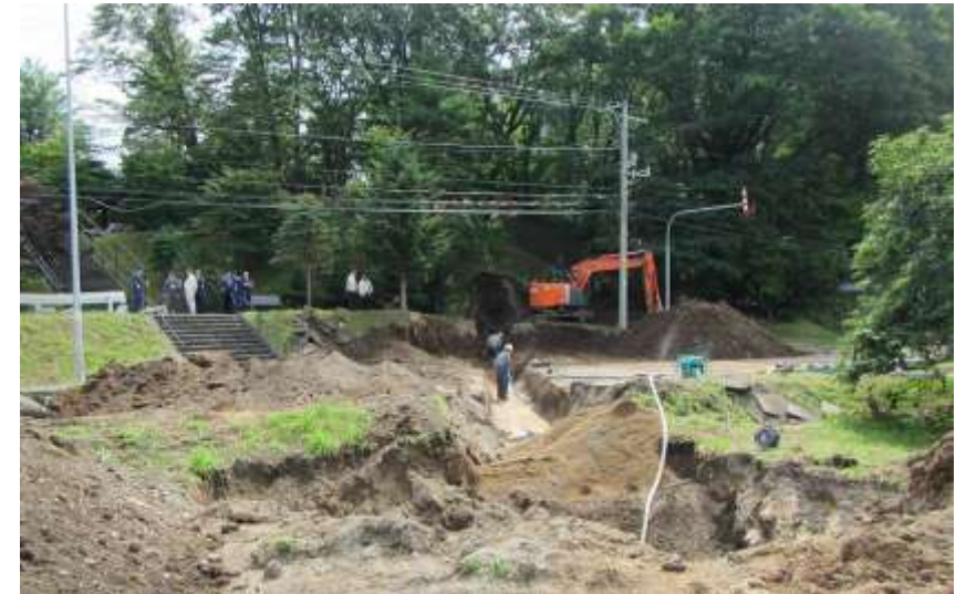
水道復旧工事(新町地区)
