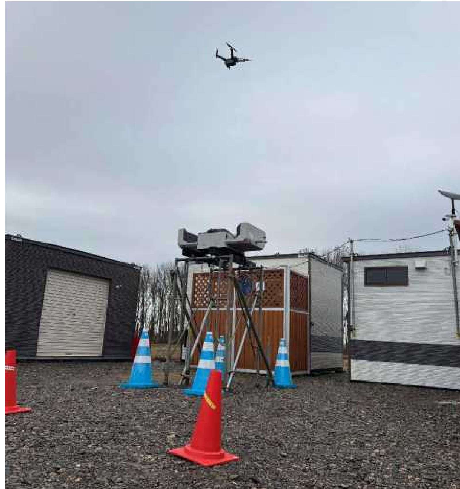
単管足場架台設置
