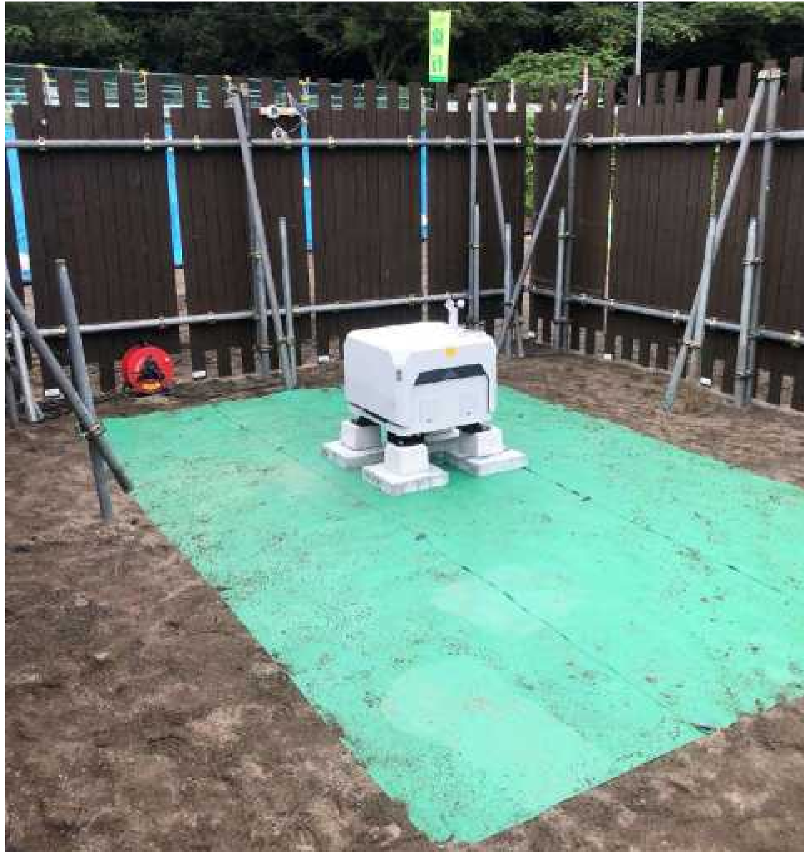
平置き + 仮囲い設置
