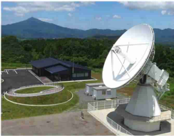
▲石岡測地観測局のVLBI観測施設 (茨城県石岡市)
