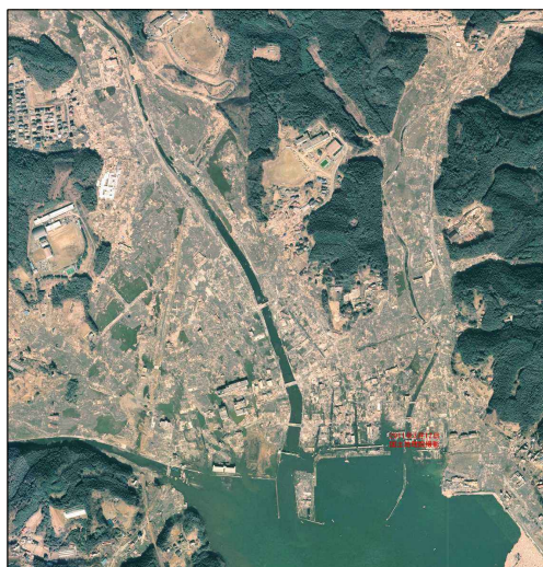
震災直後（平成23年3月12日撮影）
