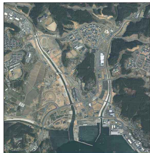
復旧・復興状況（平成31年4月撮影）
