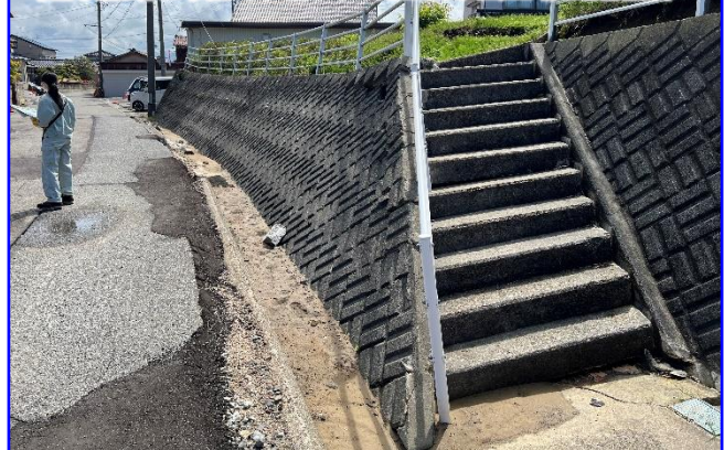
旧水部の盛土地・埋立地における液状化に伴う側方流動と噴砂(令和6年4月25日 国土地理院撮影)
