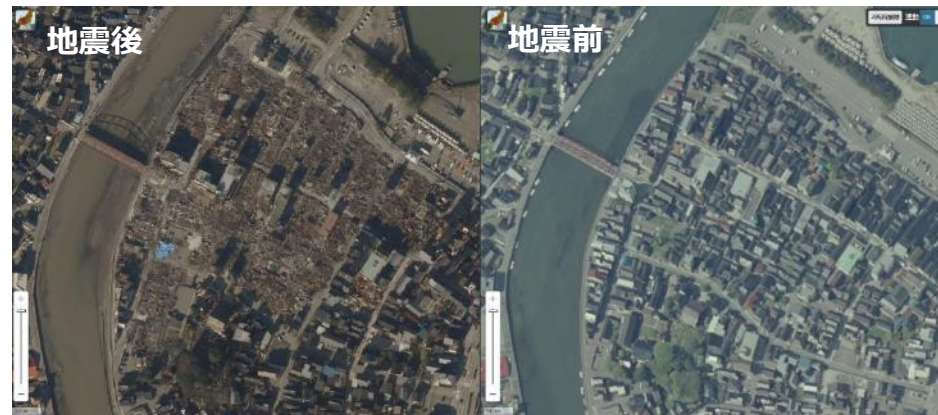
地震前後の空中写真による比較 【輪島市（朝市）の火災現場】
