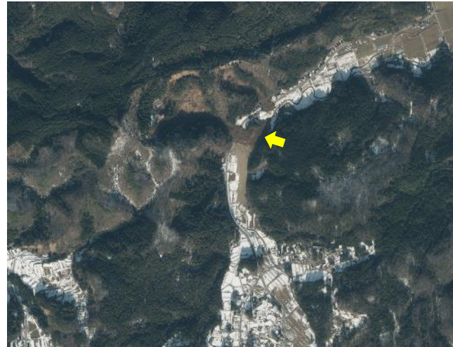
河道閉塞の状況 【輪島市町野町金蔵付近】
