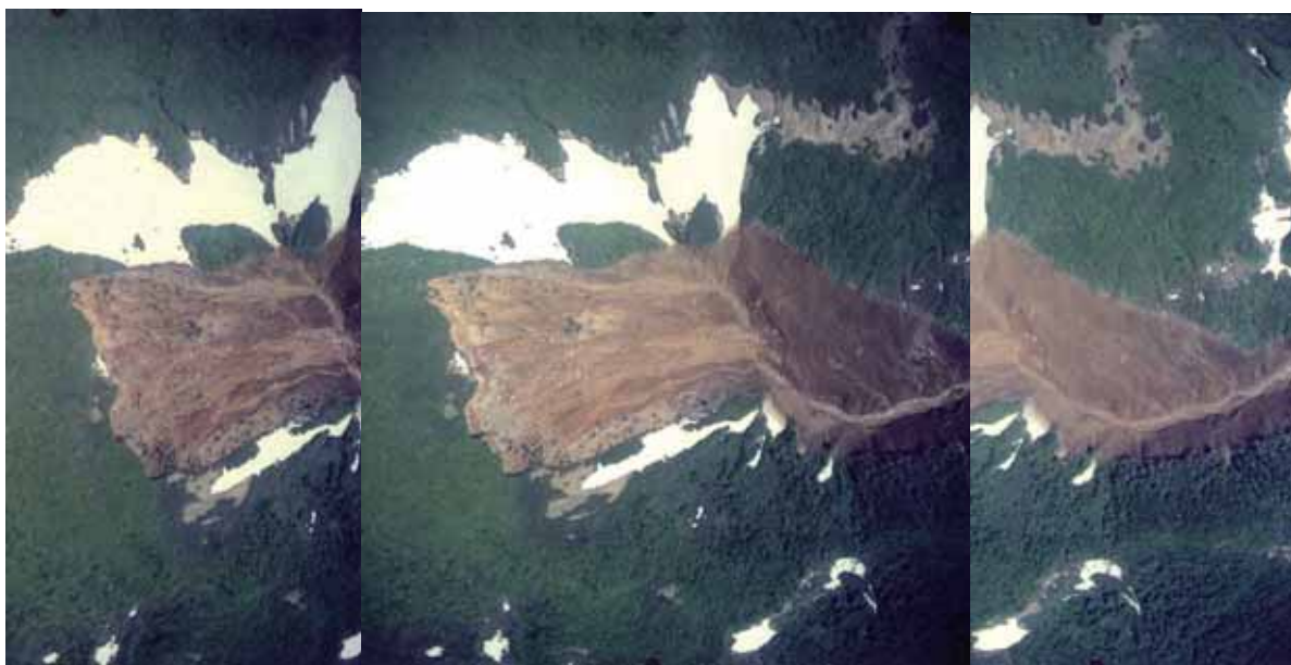
写真－36 東栗駒山東側斜面の崩壊，崩壊土砂が土石流となってドゾウ沢沿いに流下（立体視可能，国土地理院 2008 年 6 月 18 日撮影）
