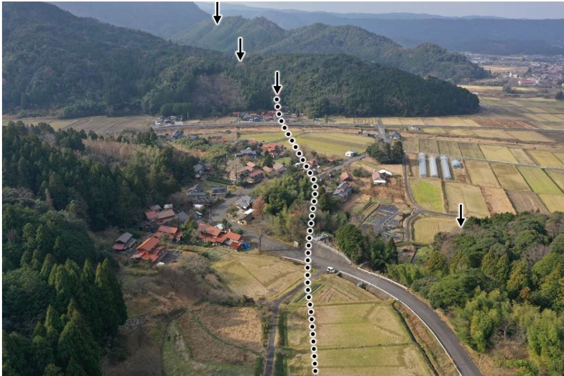
写真1 法楽寺付近 西を遠望 (2023 年 12 月 29 日筆者撮影) . 地表地震断層が出現している。
