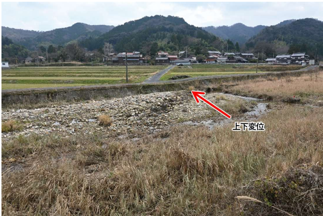
写真2 法楽寺付近 東を遠望 (2023 年 12 月 29 日筆者撮影) . 末用川右岸, 地表地震断層の変位が残っている。
