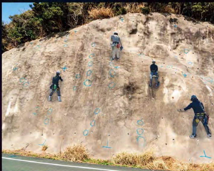
通常の工事風景
