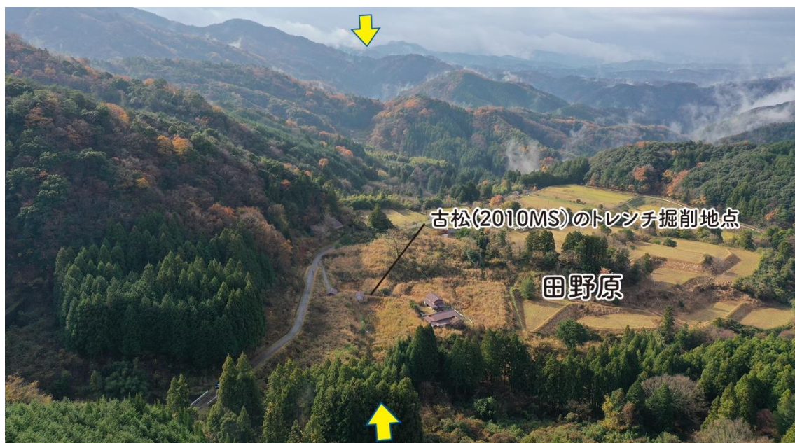
写真4 美都町田野原上空から南西に向かって撮影した空撮写真。 西への山地斜面に対して、断層崖は東向きを示す“逆向き断層崖”である (2022年12月11日筆者撮影)。
