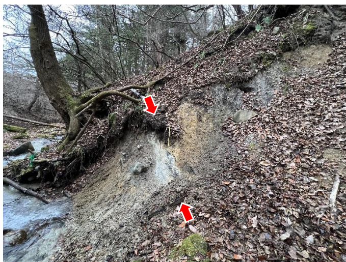
写真-3 滝道川支流右岸に見られる活断層露頭(2022年12月5日筆者撮影)。東南東に向かって撮影。 写真中央部の黄色の棒が長さ20cmの折尺。赤矢印の区間が活断層。折尺の下白色の帯が破碎帯で、それより下位が段丘礫層、上位が段丘礫層に衝上する花崗岩体。破碎帯において計測した断層面の走向・傾斜は、N60°W、60°S。
