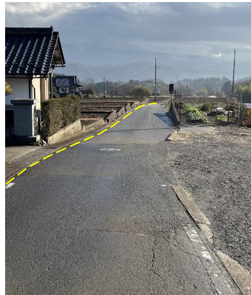
写真-6 山高神代ザクラ部分を通る撓曲地形の西側の撓曲地形（2022年12月6日筆者撮影）。撓曲地形の上端付近から東に向かって撮影。道路縁の形状（黄破線）から撓みが確認できる。
