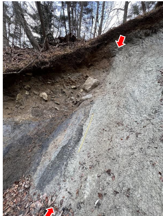
写真-4 鳳凰山断層と石空川との交差部から北西へ約450mの地点の見られる活断層露頭（2022年12月5日筆者撮影）。南南東に向かって撮影。写真中央部の黄色の棒が長さ1mの折尺。折尺より右側（西側）の、地表付近まで達する白色層が花崗岩体で、花崗岩体とその左側（東側）の黒色の破碎帯及びその上位の礫層との境界が活断層（赤矢印区間）。断層面の走向・傾斜は、N12°W、57°W。
