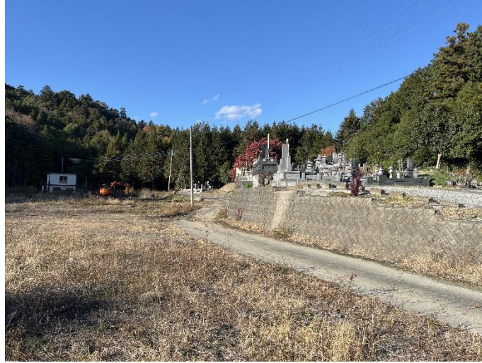
写真-11 韮崎市旭町上條南割竹ノ内付近にみられる西下りの縦ずれ変位地形（2022年12月6日筆者撮影）。北に向かって撮影。擁壁部分が変位地形に相当。
