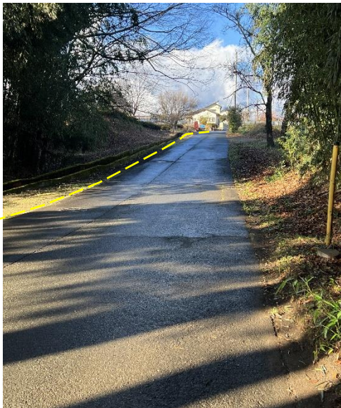
写真-5 山高神代ザクラ部分を通る撓曲地形（2022年12月6日筆者撮影）。山高神代ザクラの北側の東西方向の道路の撓曲崖下端部から西に向かって撮影。道路縁を黄破線で明示。
