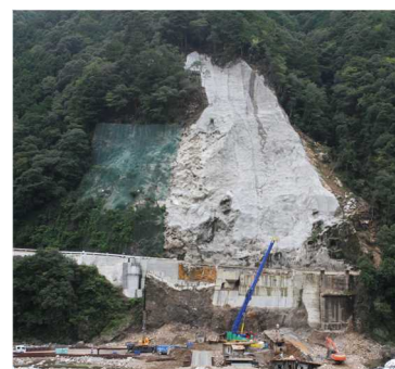
図2 浜松市天竜区原田橋（国道473号線）
