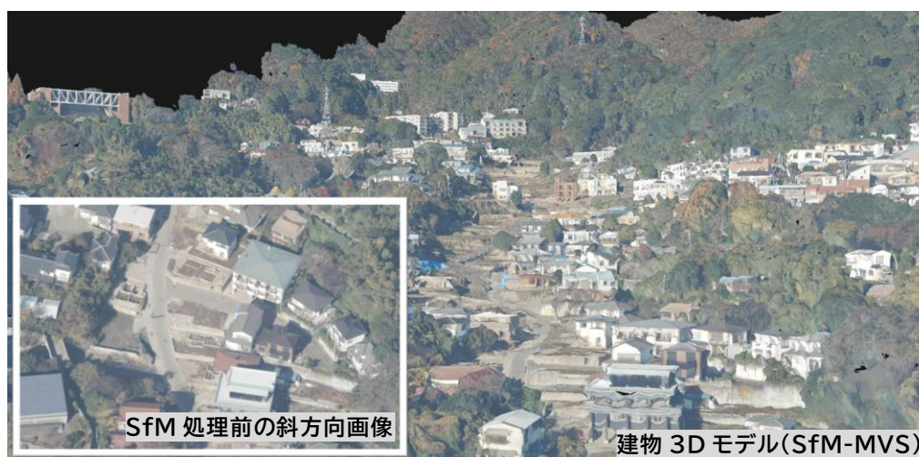
図-5 SfM-MVS で作成した熱海地区の 3D モデル（図中左下の枠内は SfM 処理前の斜方向画像）
