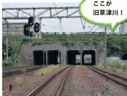
写真 1-8 地点1を地上から見たところ
