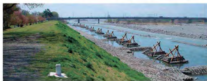
写真 2-6 現存する信玄堤 (国土交通省関東地方整備局より引用)
