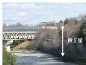
写真1-5 段丘崖に入る圏央道のトンネル
