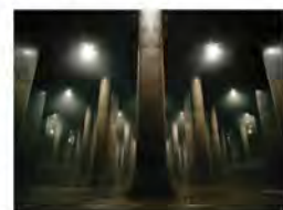
写真 2-7 首都圏外郭放水路の調圧水槽 (国土交通省江戸川河川事務所より引用) 水の勢いを弱めるための調圧水槽。広々とした空間に柱が並ぶ光景から、「地下神殿」と呼ばれています。
