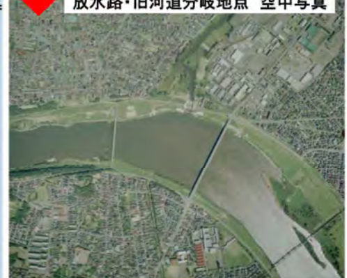
放水路・旧河道分岐地点 空中写真
