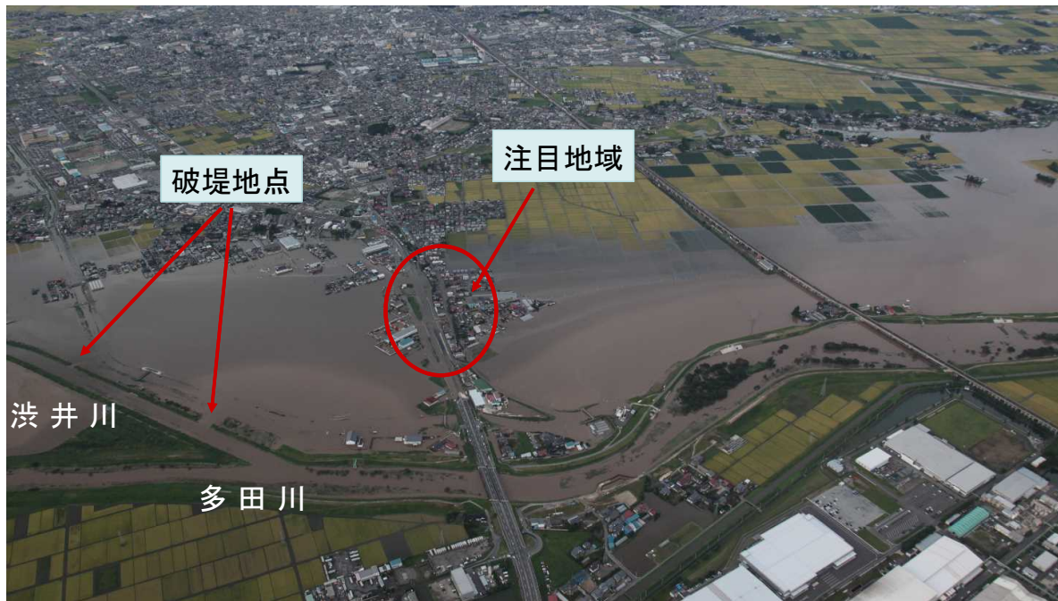
平成27年9月11日撮影 斜め写真
