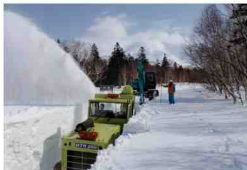
バックホウによる雪壁部の切り直し作業
