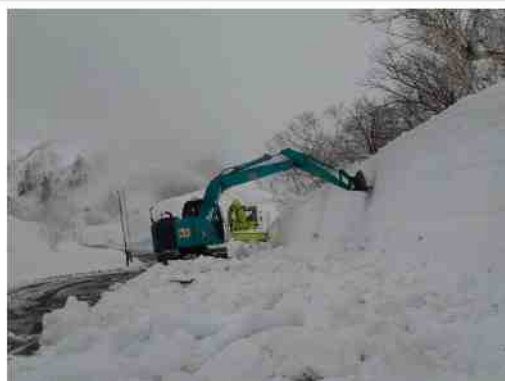
バックホウによる雪壁部の切り直し作業
