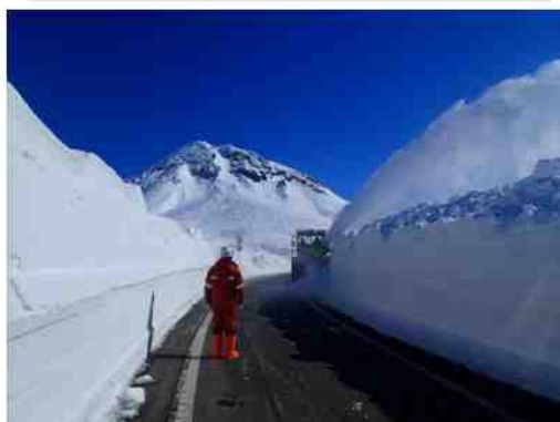
ロータリ除雪車による拡幅作業
