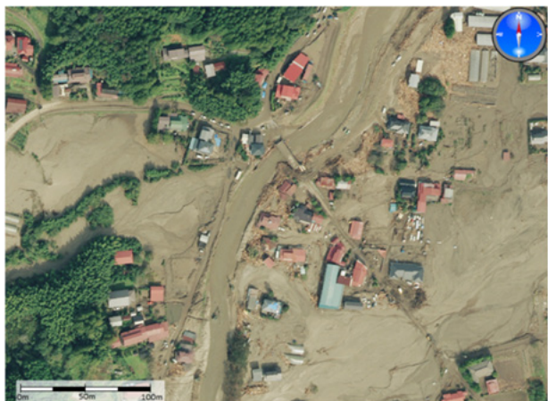
写真-3 宮城県丸森町宇和田西付近の被害状況
