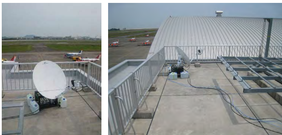
図-13 アンテナ設置状況（左側写真奥の青い機体が「くにかぜⅡ（当時）」）
