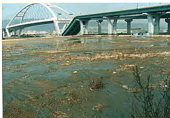
No. 1 : 西宮港大橋
