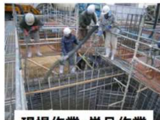
現場作業・単品作業
