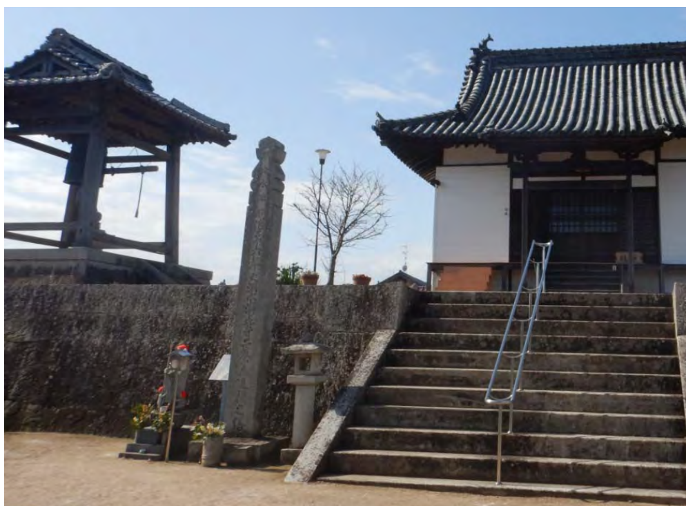
岡山県倉敷市真備町 源福寺 写真提供：中国地方整備局岡山河川事務所
