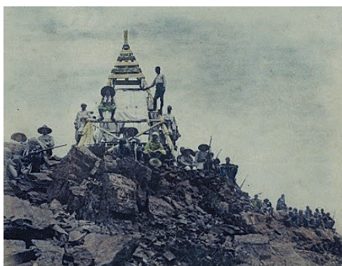
数十 km も離れた場所から測量するために三角点の上に設置された目標物（測標）
