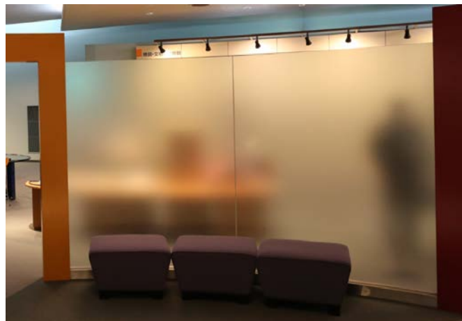
図 3-4 計測できない素材例（磨りガラス）
