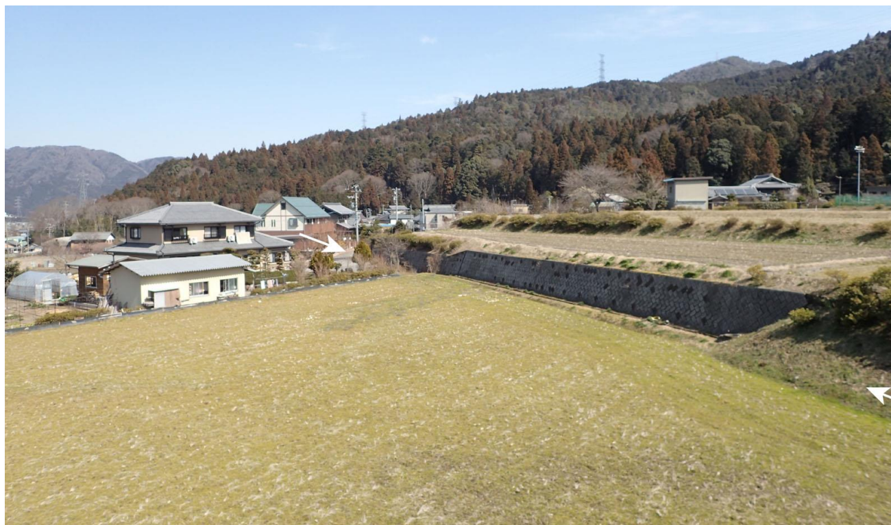
図 8 中位段丘面を変位させる上石津断層（大垣市上石津町一ノ瀬）
