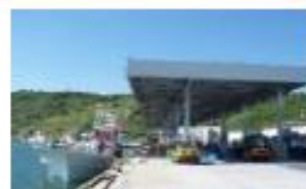
屋根付き岸壁の整備
