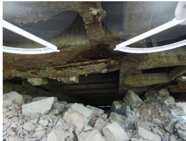
天守閣の石垣と建物の間
