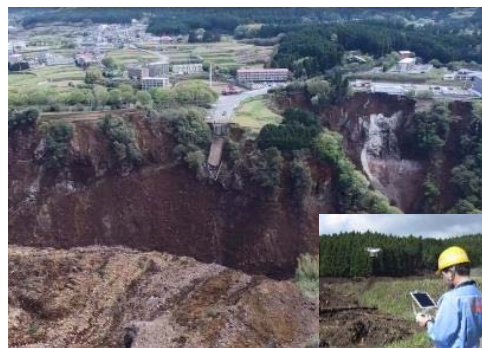
無人航空機による緊急動画撮影 立入りが困難な土砂災害現場の状況把握
