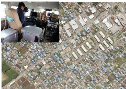
航空機による緊急撮影 広域な被災状況を迅速に把握
