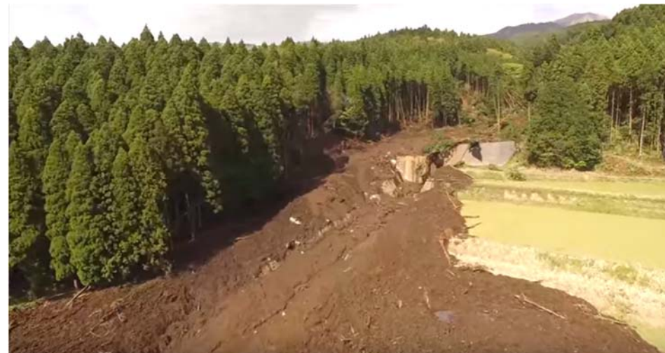
山王谷川(南阿蘇村大字長野)の土砂災害(4月17日撮影)
