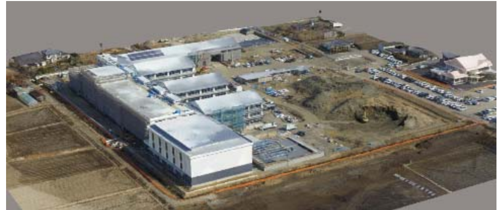
UAVによる画像からの3Dモデル(建設中の学校)
