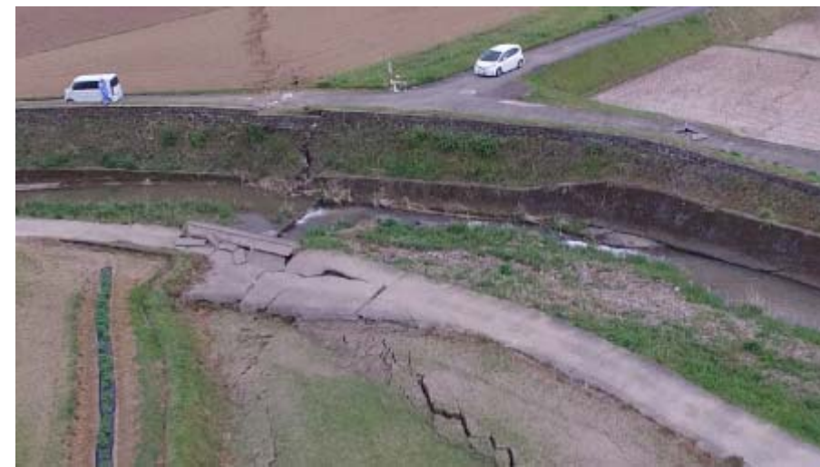
益城町下陳周辺の地表地震断層(4月16日撮影)
