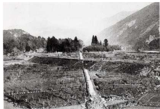
図-9 濃尾地震で出現した地震断層 (根尾谷断層) (Milne, J. and Burton, W. K. 撮影)
