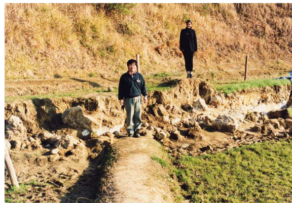
図-17 兵庫県南部地震で出現した地表地震断層(岡田篤正氏提供)
