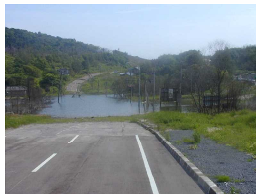
噴火による陥没で寸断された道路
