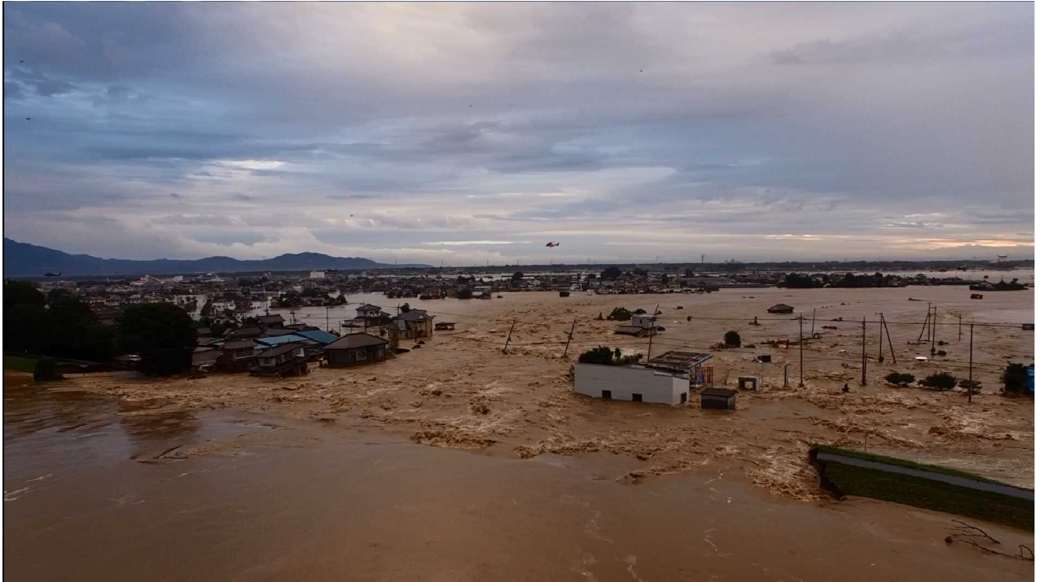
無人航空機(UAV)により鬼怒川破堤箇所の動画を撮影 撮影日時:平成27年9月10日 撮影高度:10m
