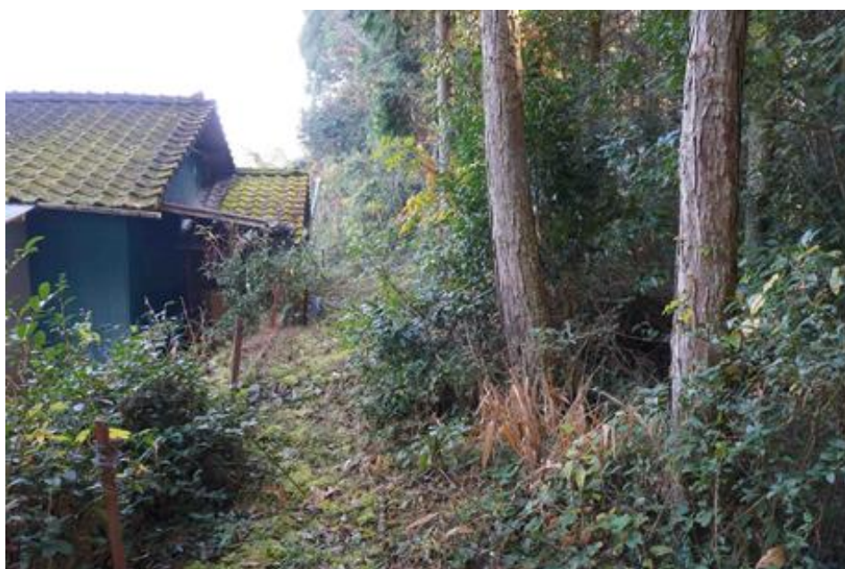
写真 3 田上南方の撓曲変位
