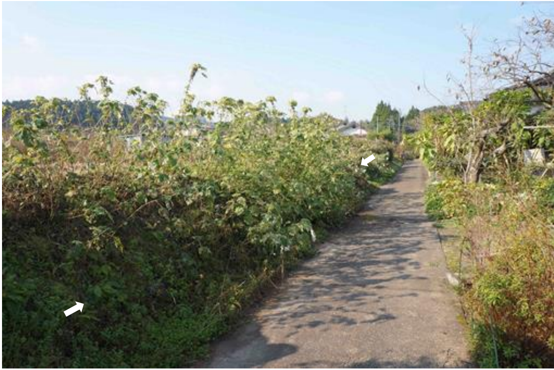
写真 13 大畑町南側の断層崖
