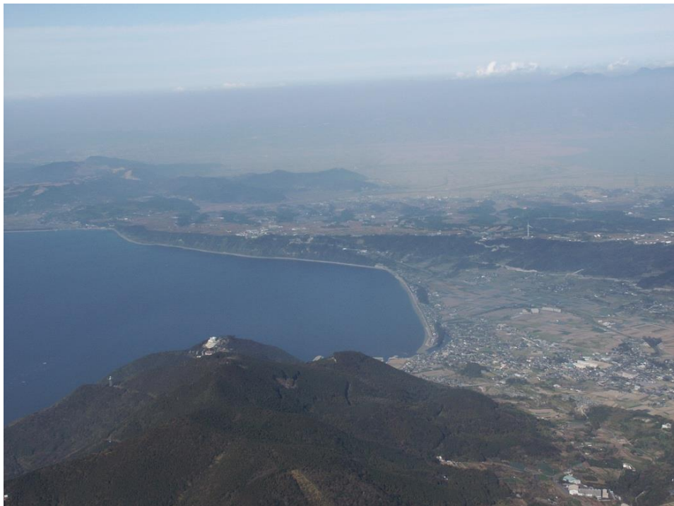
口絵 4 千々石断層西部の断層崖の空撮写真（南から北を見る）
