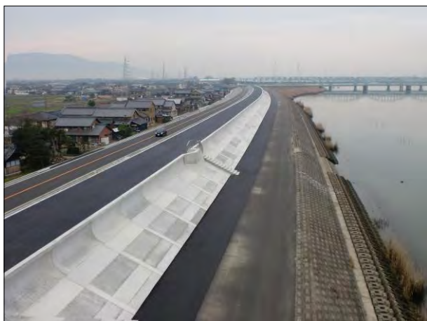
高潮堤防の遠景(平成22年3月撮影)
