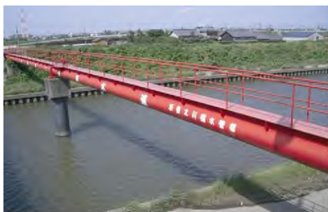
新善太川橋水管橋
