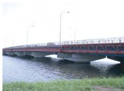
新筏川橋水管橋
