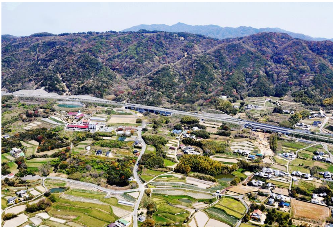
写真 5 淡路市新村付近の山麓線と丘陵性山地（頂部に淡路 CC）を北東方に望む 山麓を高速道が走るが、ほぼこの山麓線沿い志筑断層が通る。志筑断層の北部は変位地形が明瞭でないため、推定活断層として図示。2013 年 4 月 13 日岡田篤正撮影。
