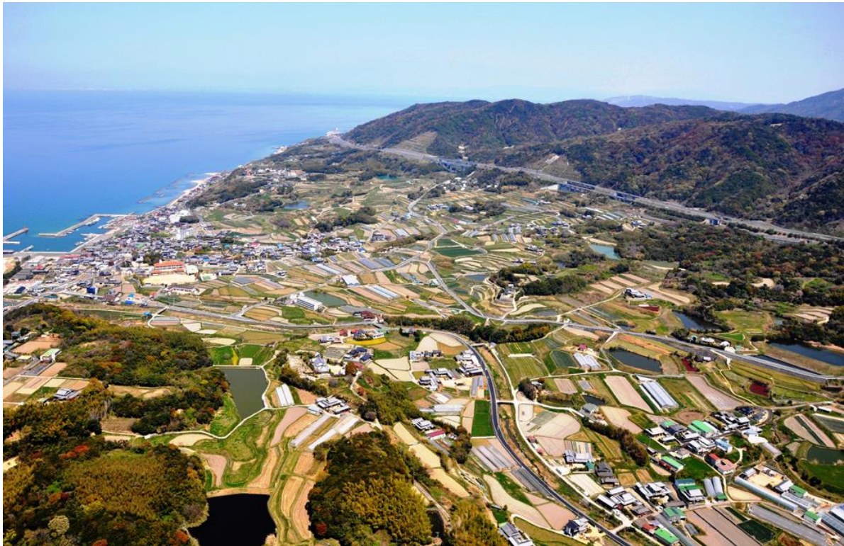
写真 3 淡路島西岸の淡路市尾崎（枯木・東）付近の地形を北方に望む
