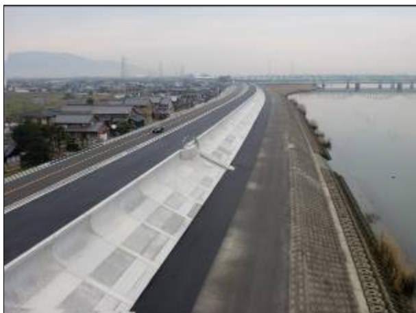
高潮堤防の遠景（平成22年3月撮影）
