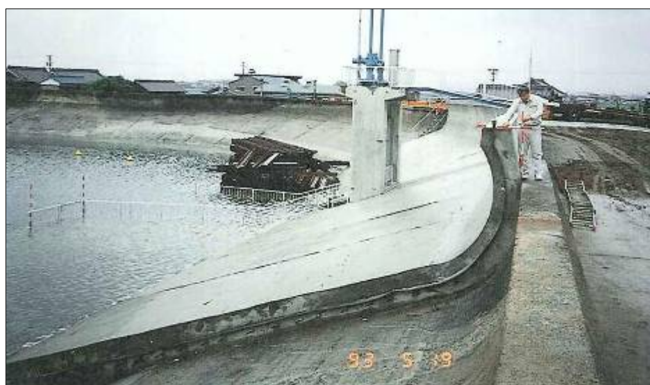
写真－9 地盤沈下対策河川事業（鍋田川下流排水機場吐出樋門設置工事） 三重県桑名郡木曽岬町源緑輪中（平成5年5月撮影）
