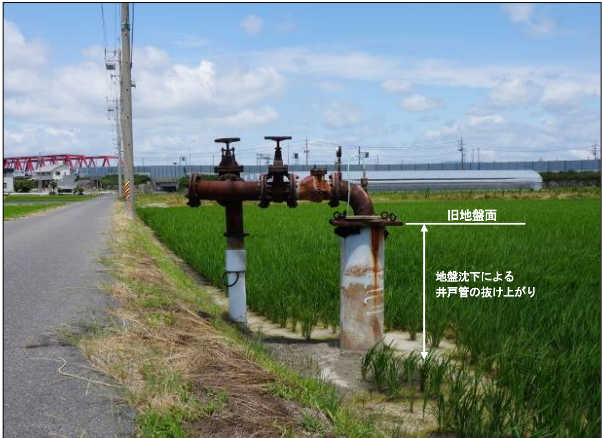
写真－1 三重県桑名郡木曽岬町の井戸の抜け上がり状況（平成26年6月撮影） ※ 近傍の水準点（C35－9）における累積沈下量：116cm（昭和36年～平成25年）
