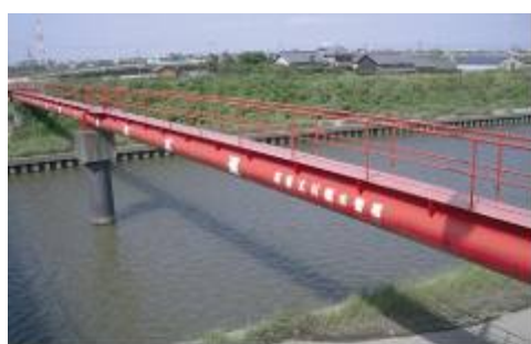
新善太川橋水管橋
