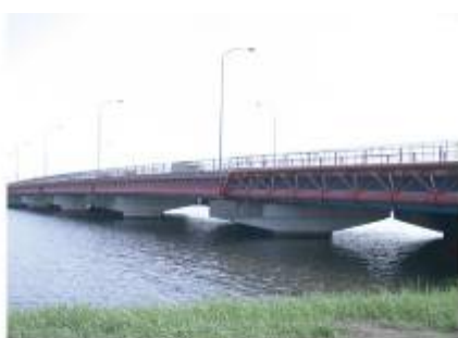
新筏川橋水管橋
