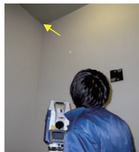
図-15 TS による検証点（矢印）座標の測量
