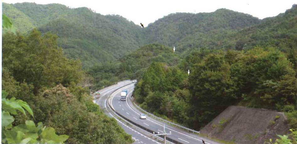
写真7 岩国市近延付近の大竹断層の変位地形
