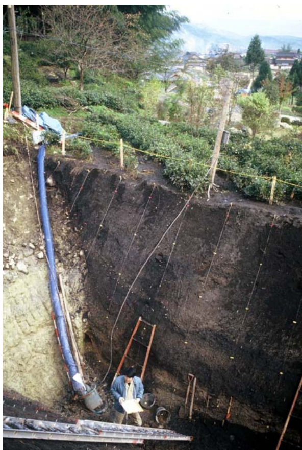
写真 3 中津川市付知町倉屋のトレンチと低断層崖
