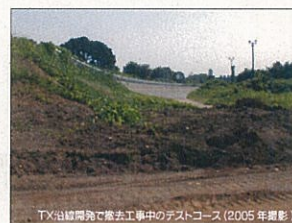
TX 沿線開発で廃去工事中のテストコース (2005 年撮影)
