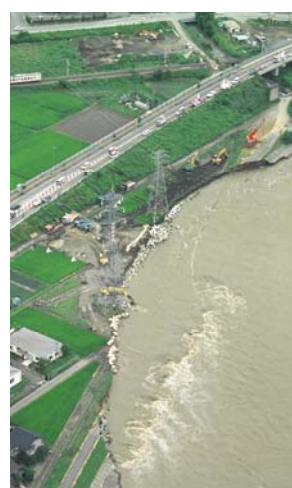
図－3 天竜川堤防決壊（箕輪町松島地区） （7月20日，日本空間情報技術撮影による）
