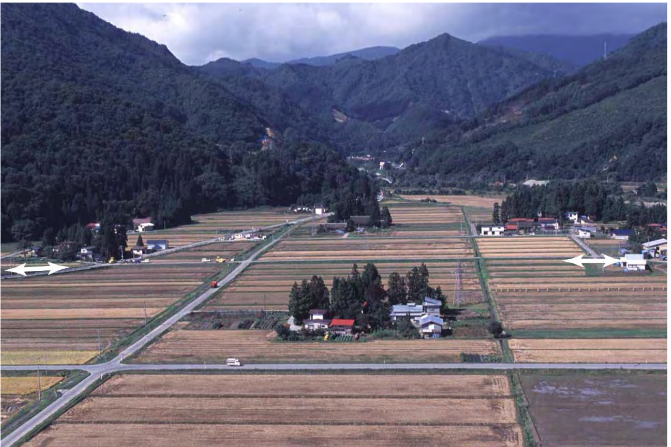
写真 11 平山付近における野川右岸の最低位段丘を変位させる低断層崖（白矢印）． （八木浩司撮影）
