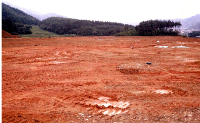
写真10 相田の工場造成中の様子（岡田1974年撮影）。ブルドーザーで平坦化された工場用地を掘り起こし、断層を含む地質が平面的に広く観察された（岡田，1984）。背後左の鞍部を地質境界の三方断層が、右を活断層としての三方断層が走る。
